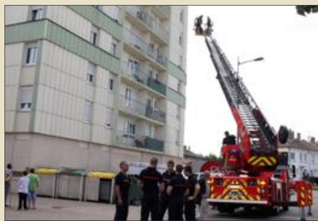
Les secours sont intervenus pour une rupture de canalisation qui a fait des dégâts dans un appartement tour Roland. Photo Pierre HECKLER
